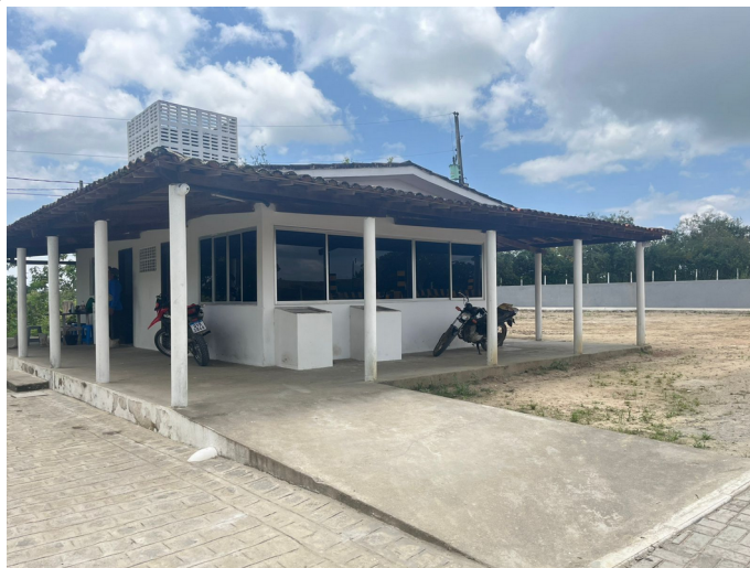
Figura 05 – Sede administrativa do Aterro Sanitário do COMAGSUL.
