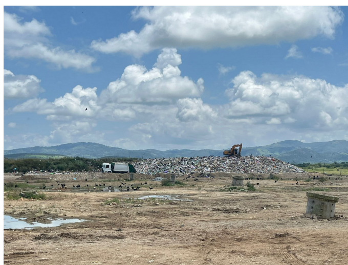
Figura 04 – Área de compactação do Aterro Sanitário do COMAGSUL.
